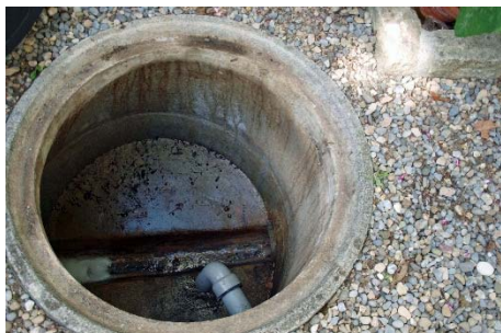
Foto 7 Schacht DN 600 mit Falz / LW 60 cm **Falz innen Ø ca. 660 mm / Falzhöhe 35 – 42 mm
