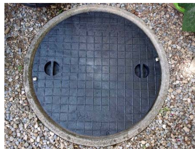
Foto 8 Schachtdeckel SOLO befestigt in Falz
