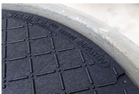
Foto 10 SOLO-Deckel in Falz von Brunnenring DN 600 ohne Rahmen eingelegt montiert. Je nach Fabrikat kann wegen abweichender Falzhöhe des Betonbauteils einen Niveauunterschied von 1 – 1,5 cm entstehen. Achtung: allenfalls Gefahr Stolperfälle
