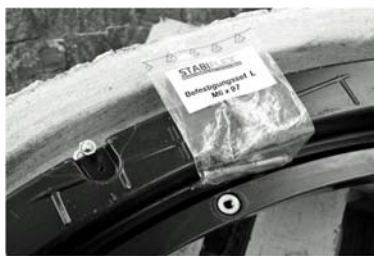
Foto 7 STABIFLEX BASIC XXL Montage auf Betonrohr DN 1000. Blockrahmen befestigt im Falz. Befestigung mit 2 Lastankern M6 x 97 mm (B-Set L)
