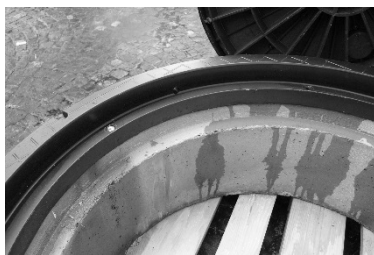
Foto 4 STABIFLEX BASIC XXL Montage auf Betonrohr DN 800. Blockrahmen befestigt auf Vaterstück. Befestigung mit 2 Lastankern M6 x 97 mm (B-Set L)
