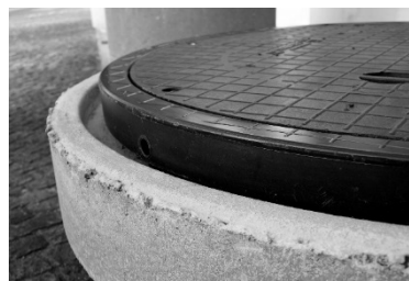
Foto 8 STABIFLEX BASIC XXL Blockrahmen, aussen Ø 1040 mm. Montiert auf DN 1000 Normalbetonrohr-/Brunnenring. ist die Aufbauhöhe ca. 25 – 30 mm (ca. 40 mm im Falz)
